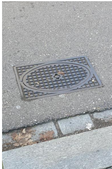
Abbildung 12: Deckel eines Unterflurhydranten in Altstetten Stadt Zürich
