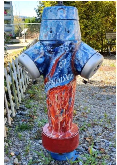
Abbildung 16: Bemalter Hydrant in Schlieren ZH
