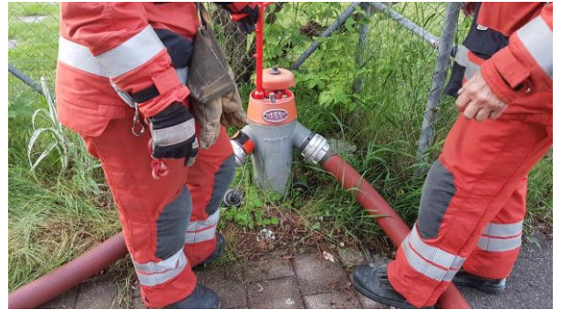
Abbildung 8: Inbetriebnahme eines Hydranten mit Anschluss beider Arme.
