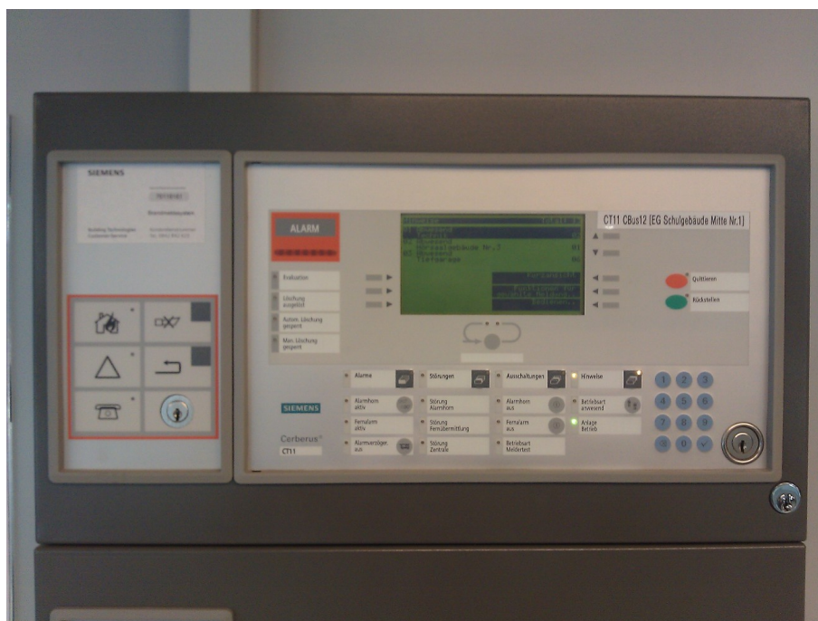
Abbildung 2.4: Ein Bedien-Terminal einer Brandmeldeanlage
