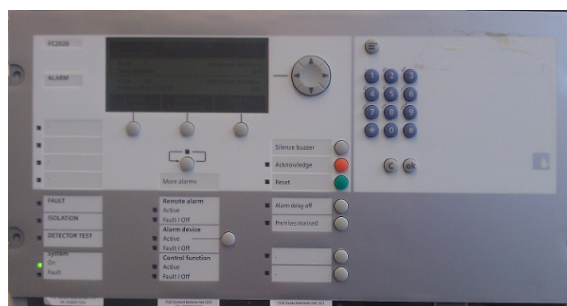
Abbildung 1.2: Bedieneinheit einer FS20 Brandmeldezentrale
