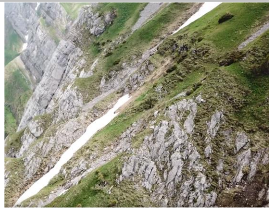
Blick über steiles und steinschlaggefährdetes Gebiet unterhalb des Wanderweges von der Schwägalp auf den Säntis
